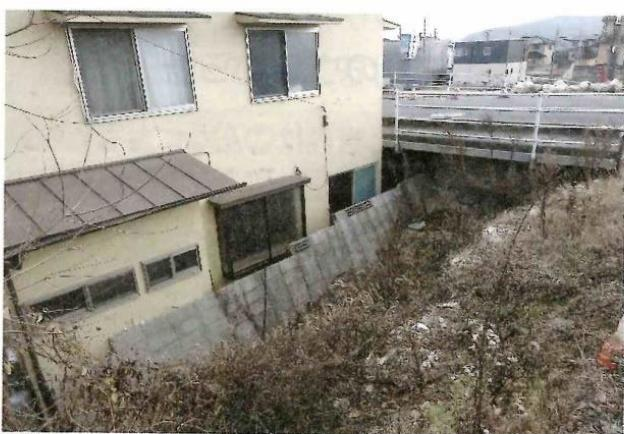
写真2 浸水した建物と倒されたブロック塀（筆者撮影）
