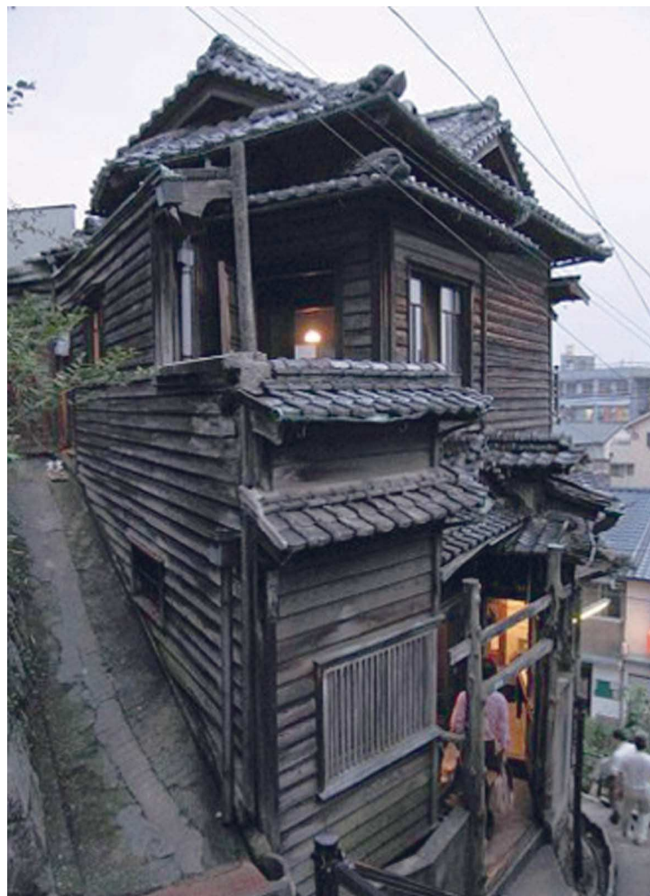
写真3 コミュニティスペースとして甦った古民家 （「尾道空き家再生プロジェクト」より転載）
