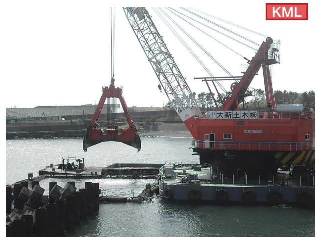
写真2 港内に堆積した土砂を浚渫する専用船 (富士市, 田子ノ浦港)
